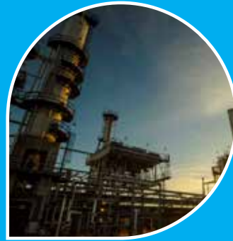
Programación y realización de tres importantes Paros Programados de Planta
