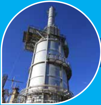
Conclusión del Proyecto del Horno 1H-1001A
